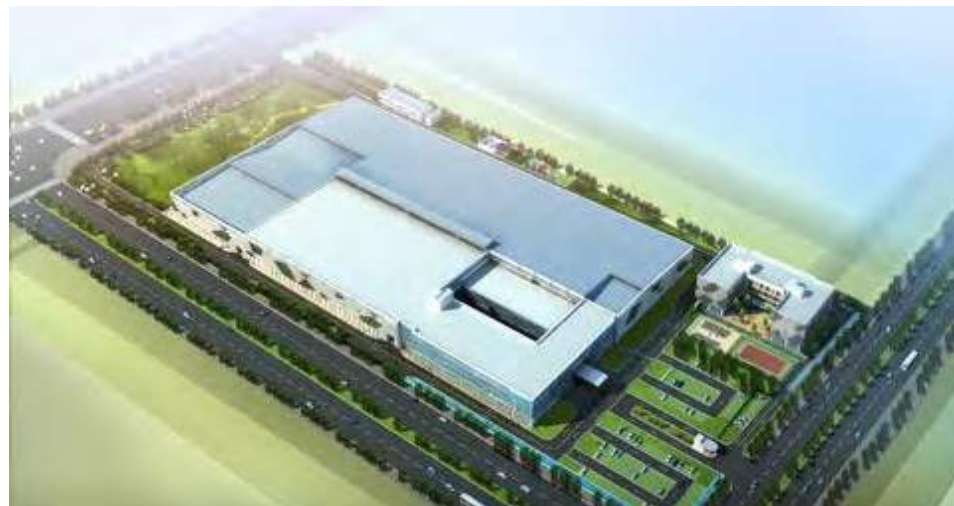
温岭东部新区厂房
